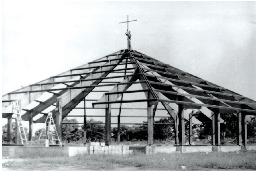
La charpente de la chapelle de Ouangolodougou.
