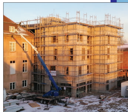
Travaux de rénovation à l'EHPAD des Missions Africaines à St-Pierre.
